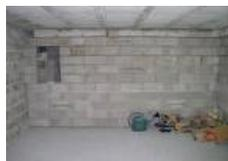
Réalisation de murs refends en béton cellulaire de 0,20 ou 0,10 m y compris linteaux, chaînages et raidisseurs verticaux et horizontaux, hourdés au mortier de ciment pour réalisation.
