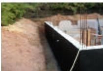
Les ouvrages de maçonnerie enterrés recevront sur leur face extérieure ( côté terre ) un enduit de protection en peinture bitumineuse avant remblaiement.
